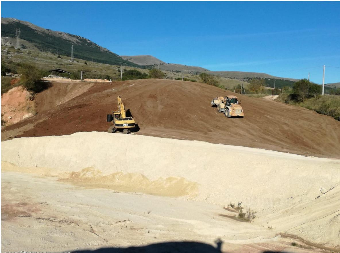
Figura 2. Discarica di Inerti: realizzazione dello strato superficiale del pacchetto di chiusura con terra vegetale.
